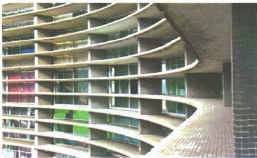
Figure 3.19 Oscar Niemeyer, Edificio Copan, 1957
